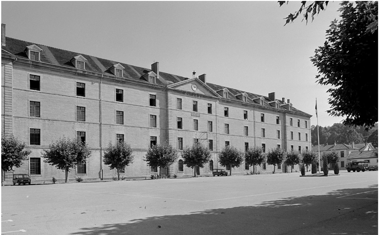
Façade antérieure, partie droite.
