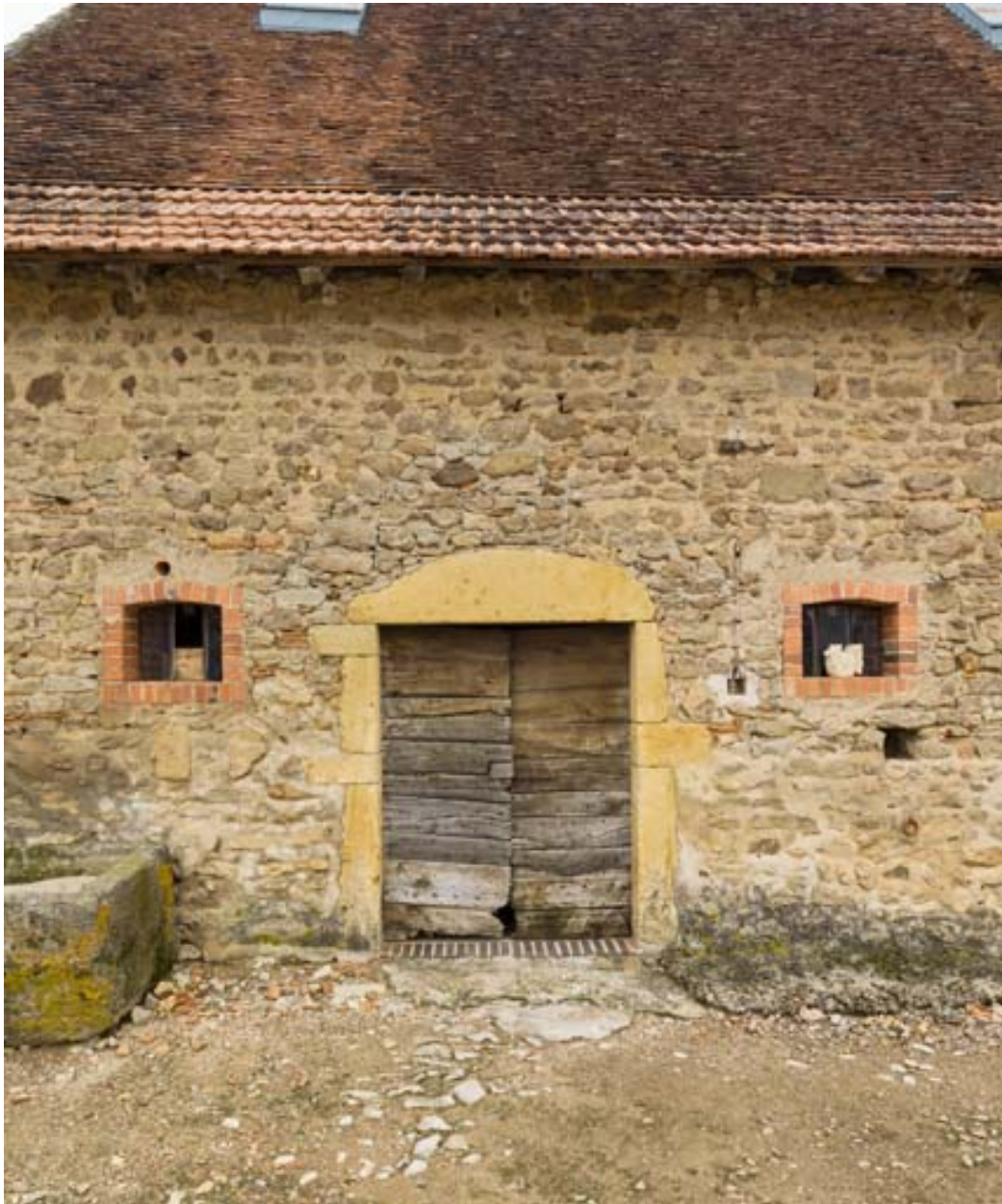
Etable. Détail de la travée ouest.
