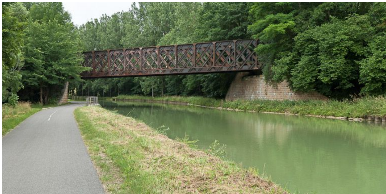
Vue d'ensemble du pont ferroviaire.
