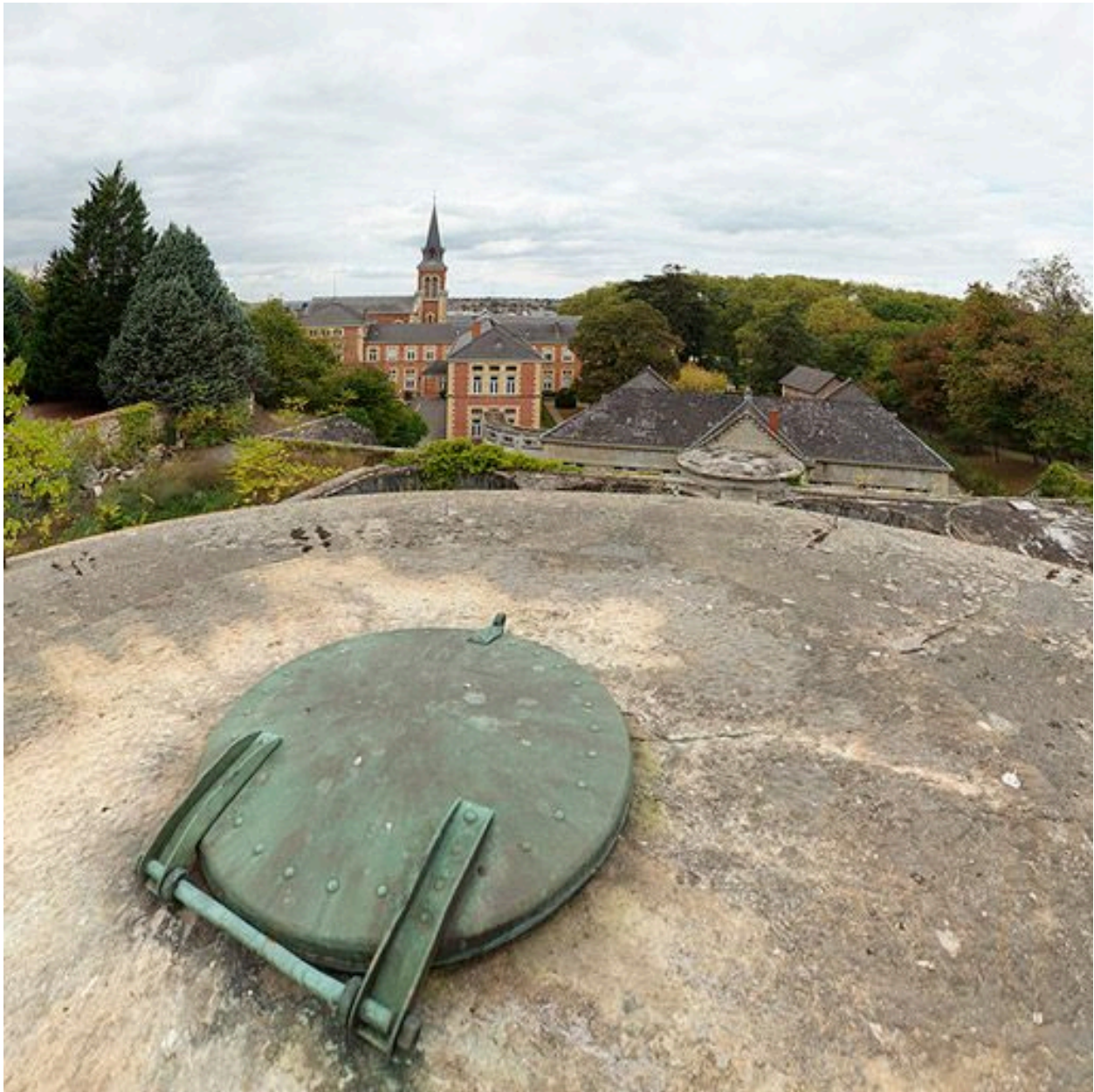
Vue d'ensemble de l'hôpital avec le trou d'homme du château d'eau au premier plan.
