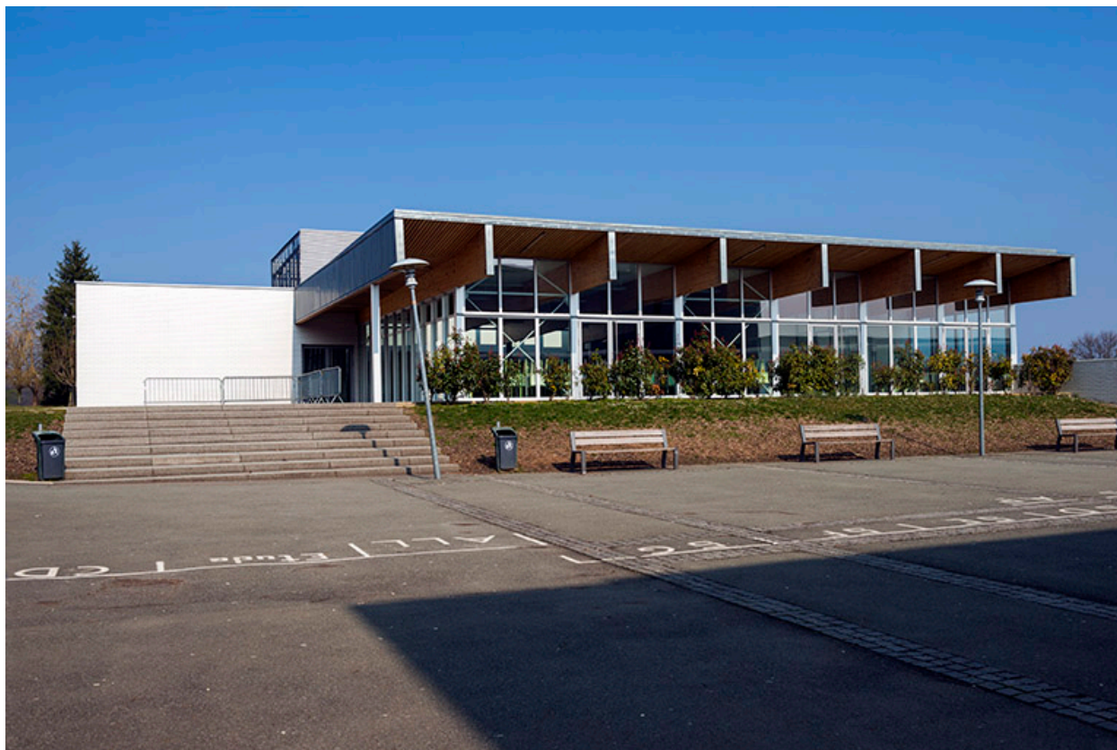
Façade sud de la cantine.
