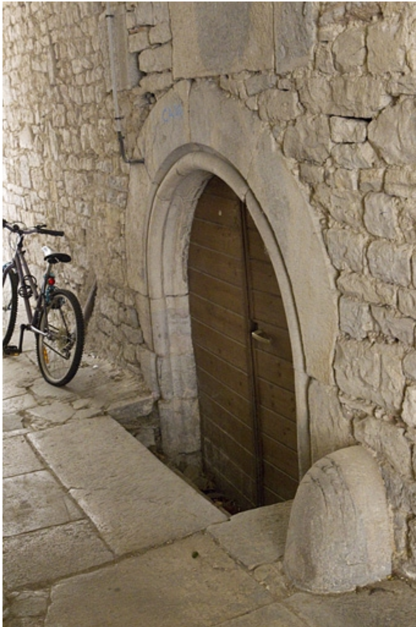
Détail de l'entrée de la cave de la maison entre les deux cours.
