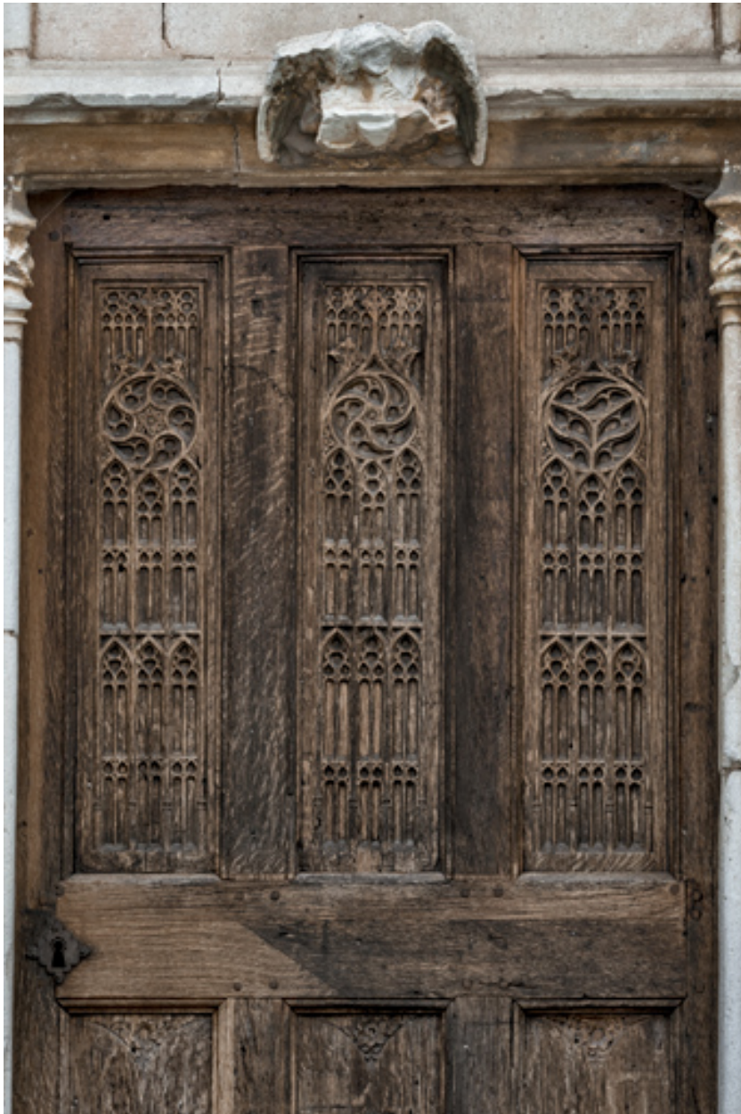
Partie supérieure, décor de fenestration.
