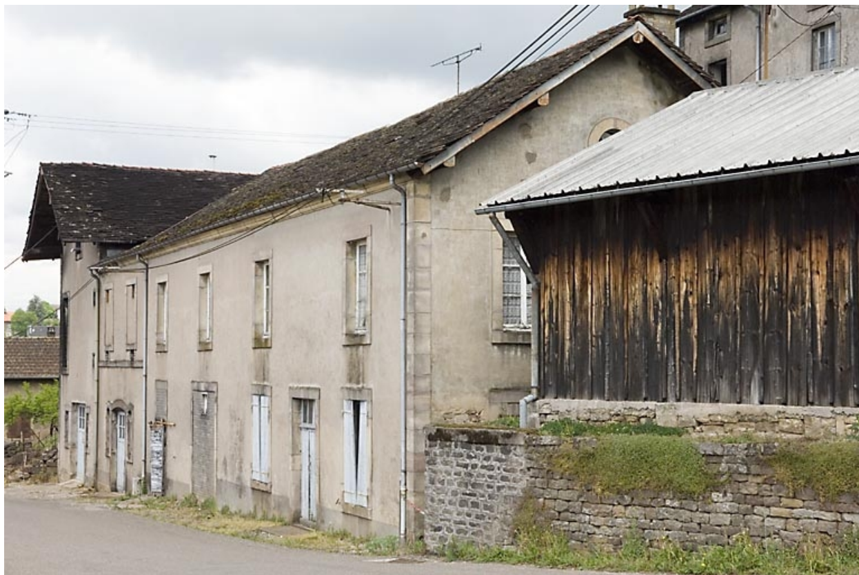
La menuiserie. Vue depuis le sud.
