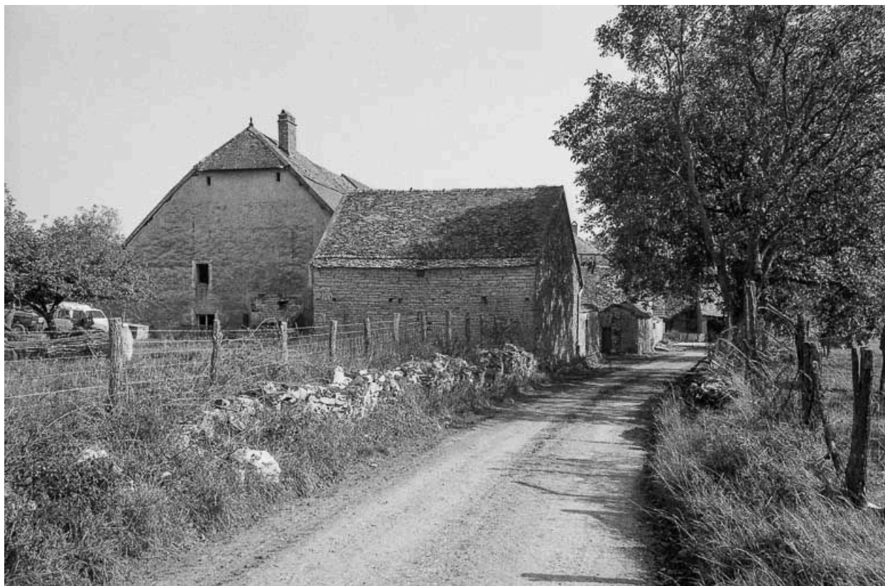
Ferme située route de Mont-lès-Etrelles à Villers-Chemin.
