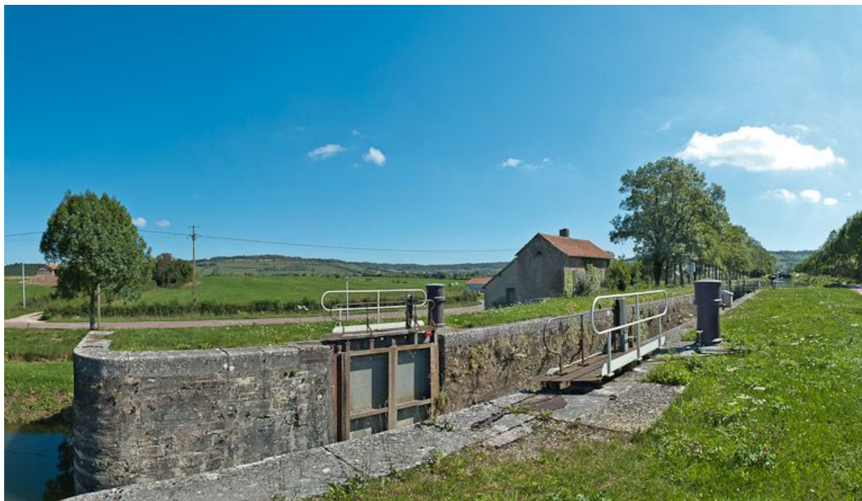
Vue du site d'écluse depuis l'aval.
