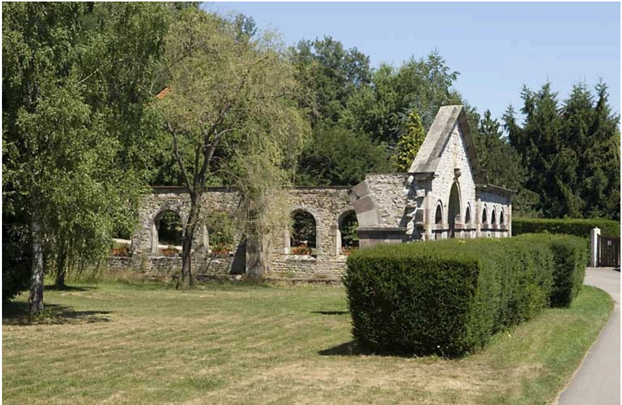
Vestiges de l'atelier de fabrication. Vue d'ensemble.
