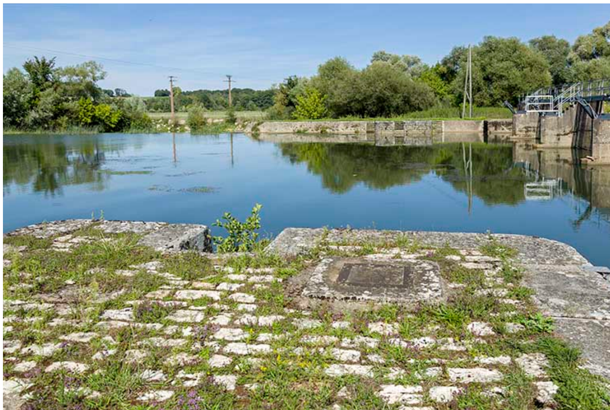
Emplacement de l'ancien barrage à aiguilles.
