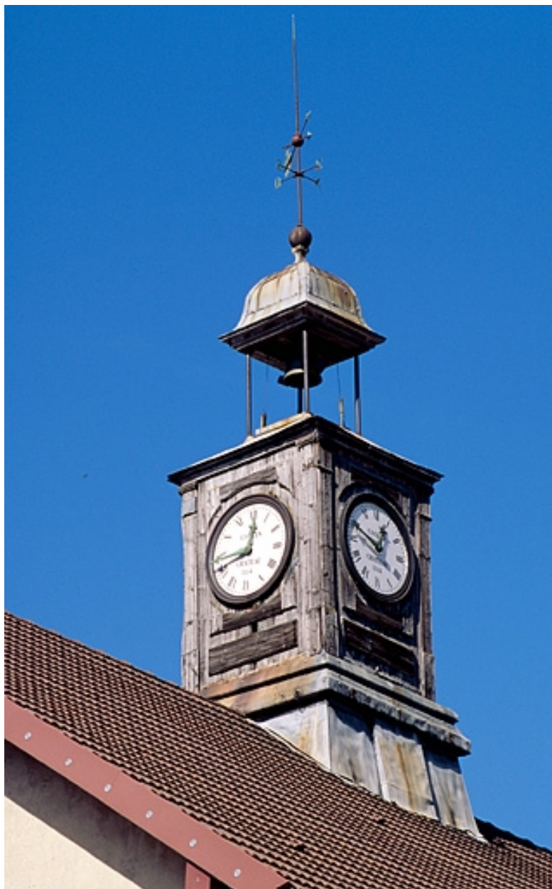
Foncine-le-Haut : clocheton de l'usine d'horlogerie Château.
