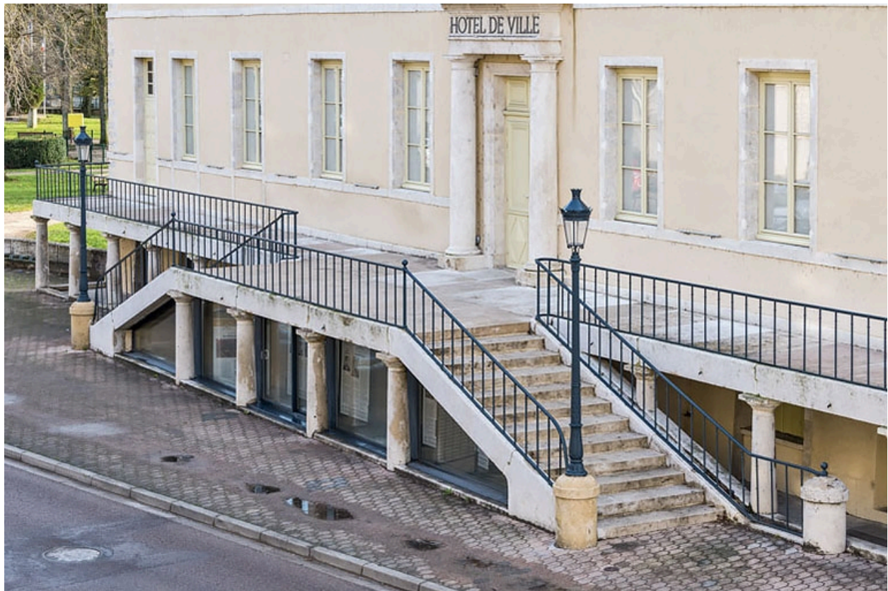
Aile nord, façade antérieure : escalier.
