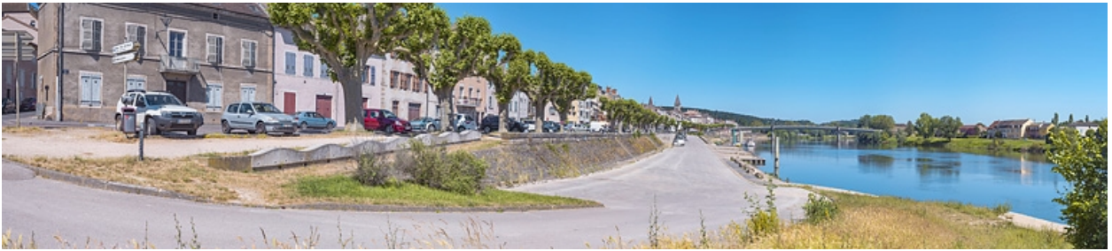
Vue d'ensemble du quai sud.
