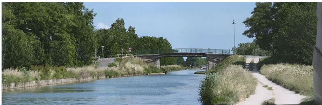
Vue d'aval, le pont dans son environnement.
