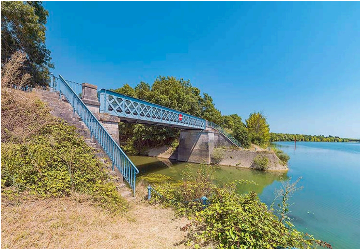
Vue d'ensemble du pont sur la Dheune.
