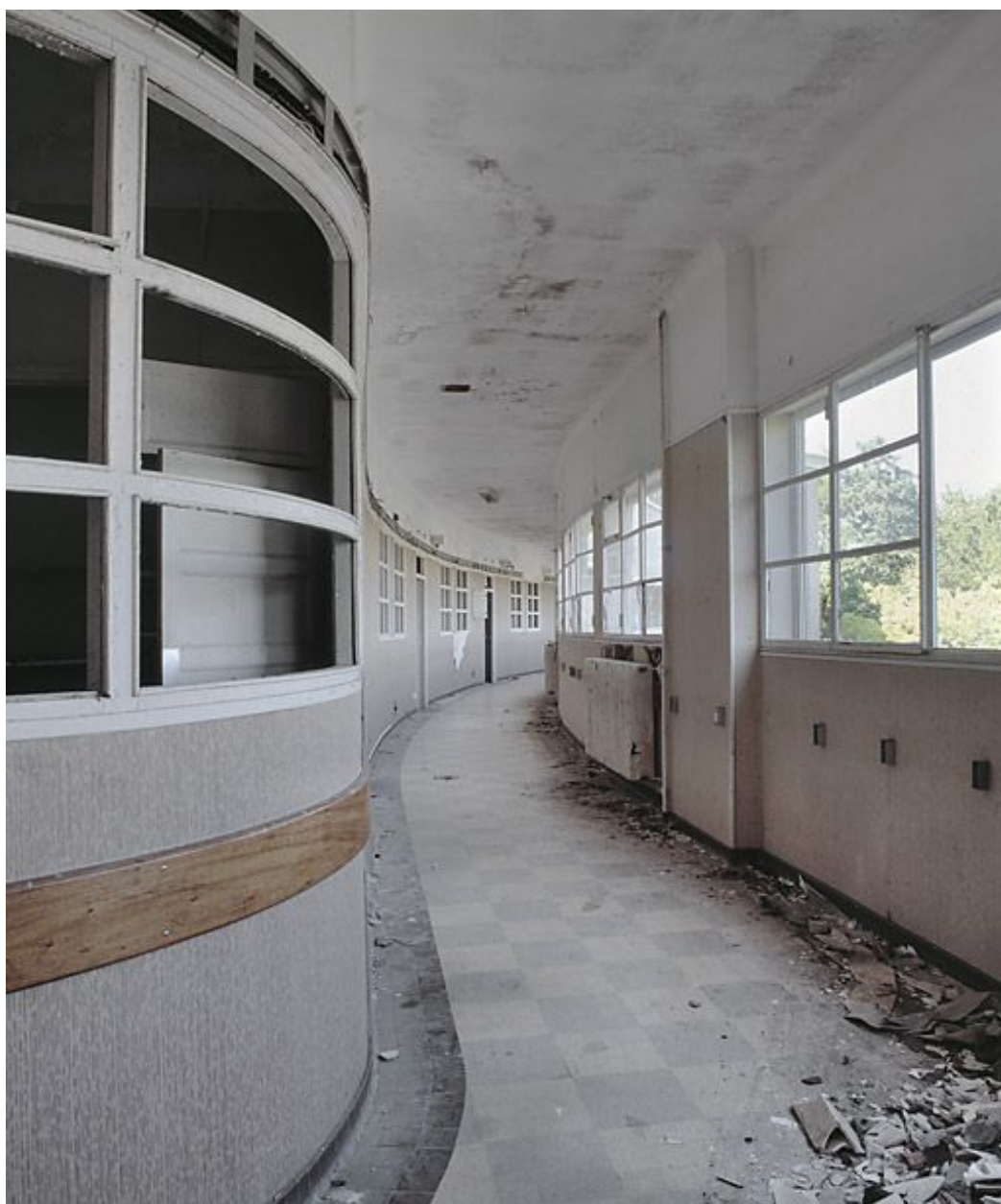
Aile ouest, couloir nord.
