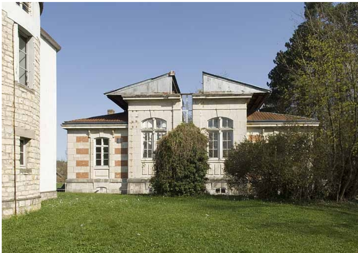
Elévation sud du pavillon, toiture ouverte.
