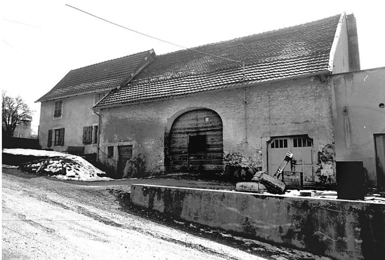
Montbouton : ferme située 11 Grande Rue.
