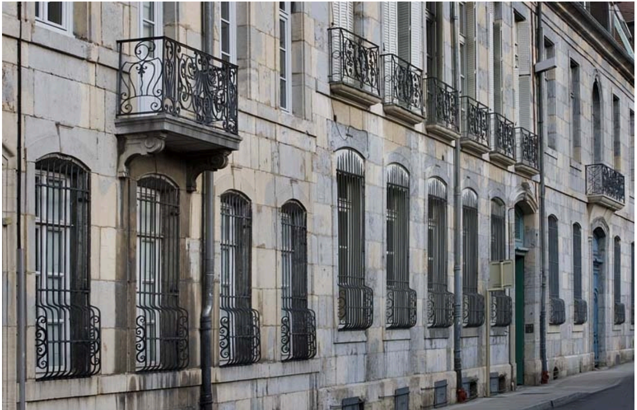
Vue rapprochée de la façade sur rue : de trois-quart gauche.
