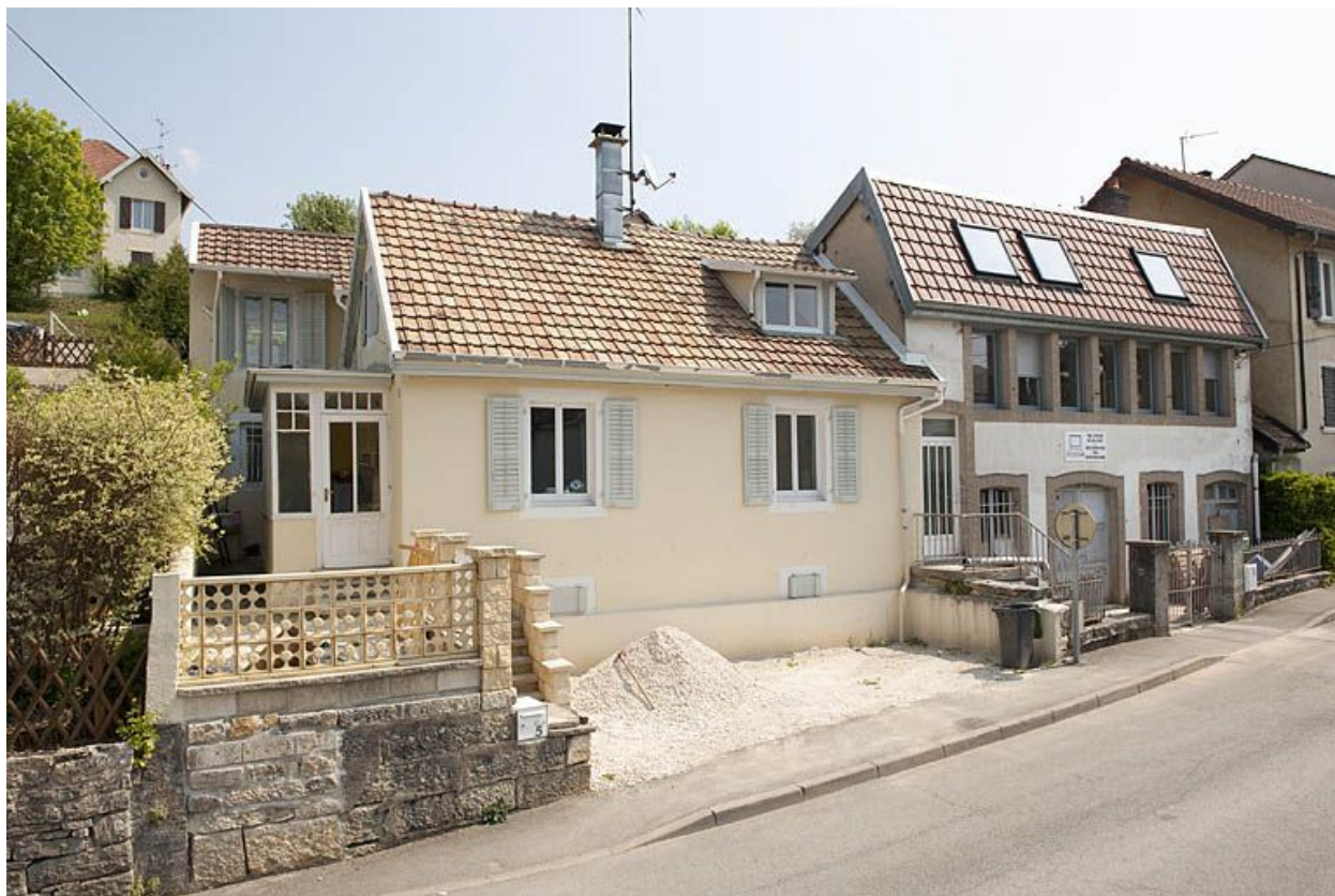
Logement et atelier depuis le nord-ouest.
