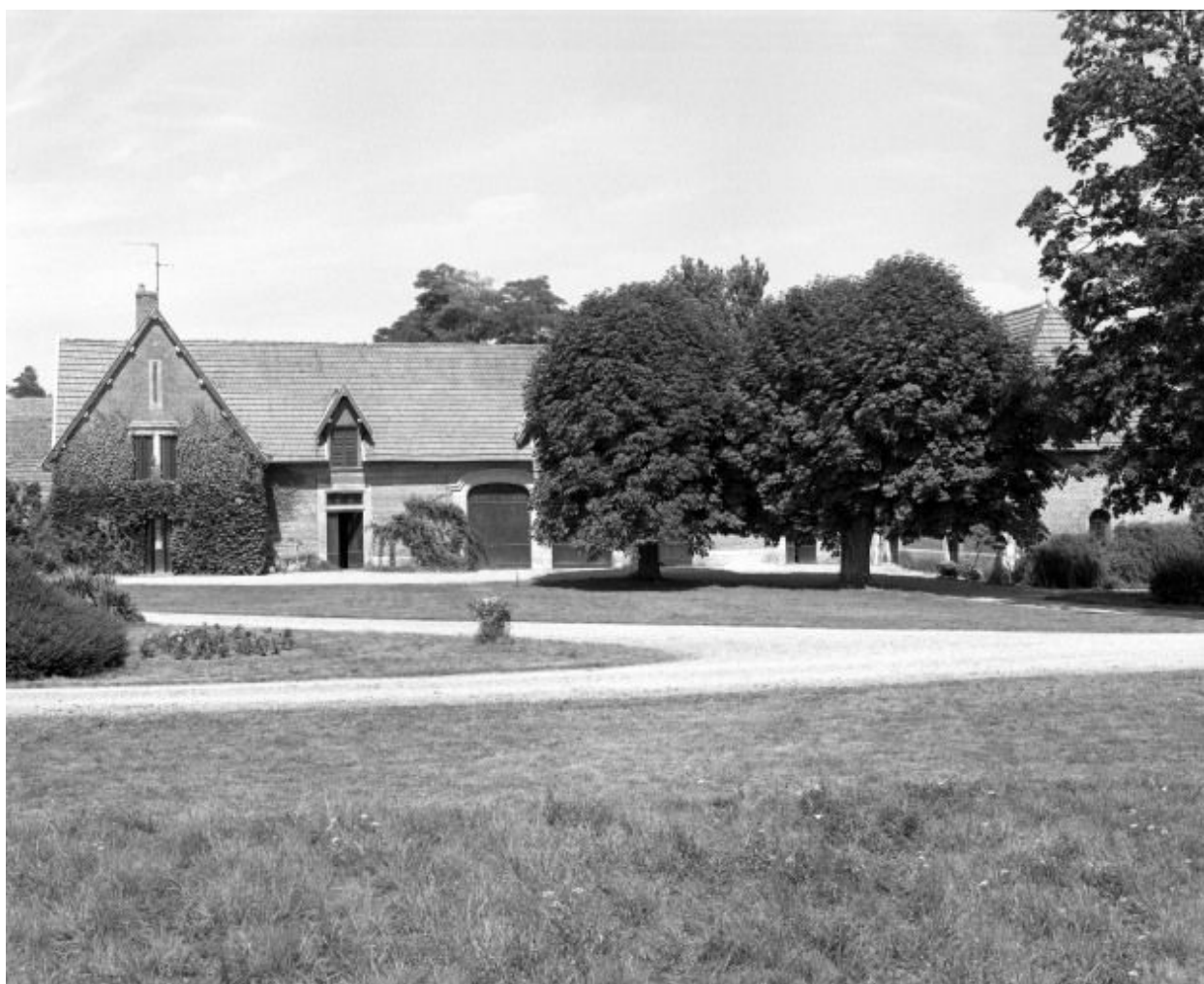
Communs et dépendances, façade antérieure.
