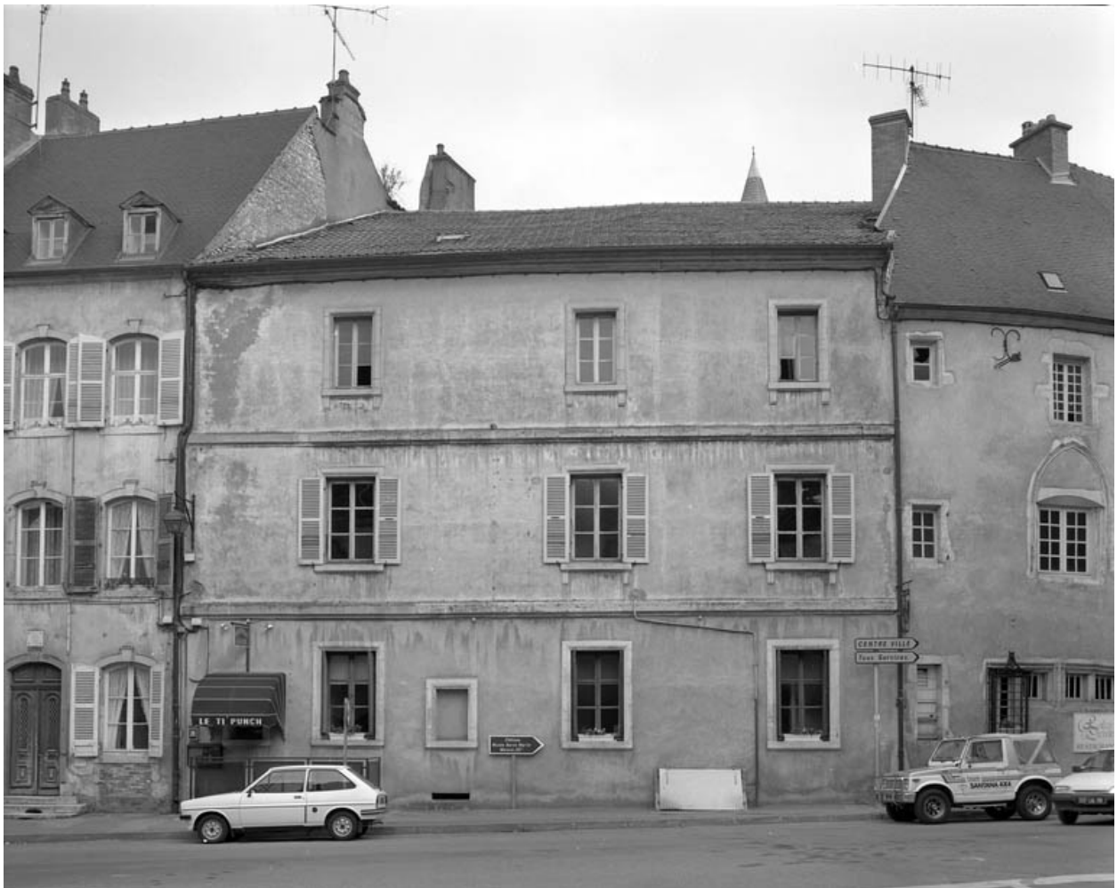
Bâtiment central : façade antérieure, de face.
