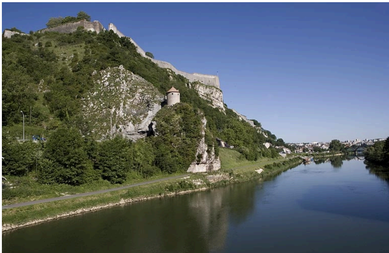
Vue d'ensemble du quai depuis l'amont.
