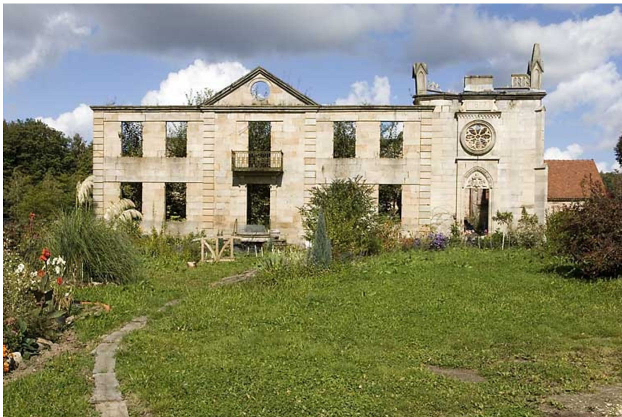
Logement patronal et chapelle. Façade antérieure.
