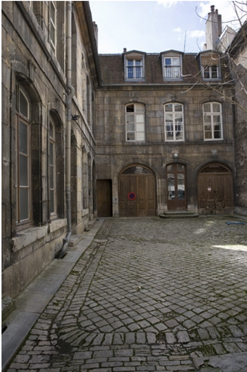
Vue d'ensemble de l'aile en fond de cour.
