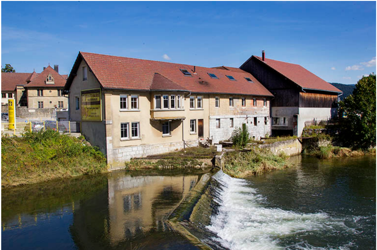
Façades postérieure et latérale droite.
