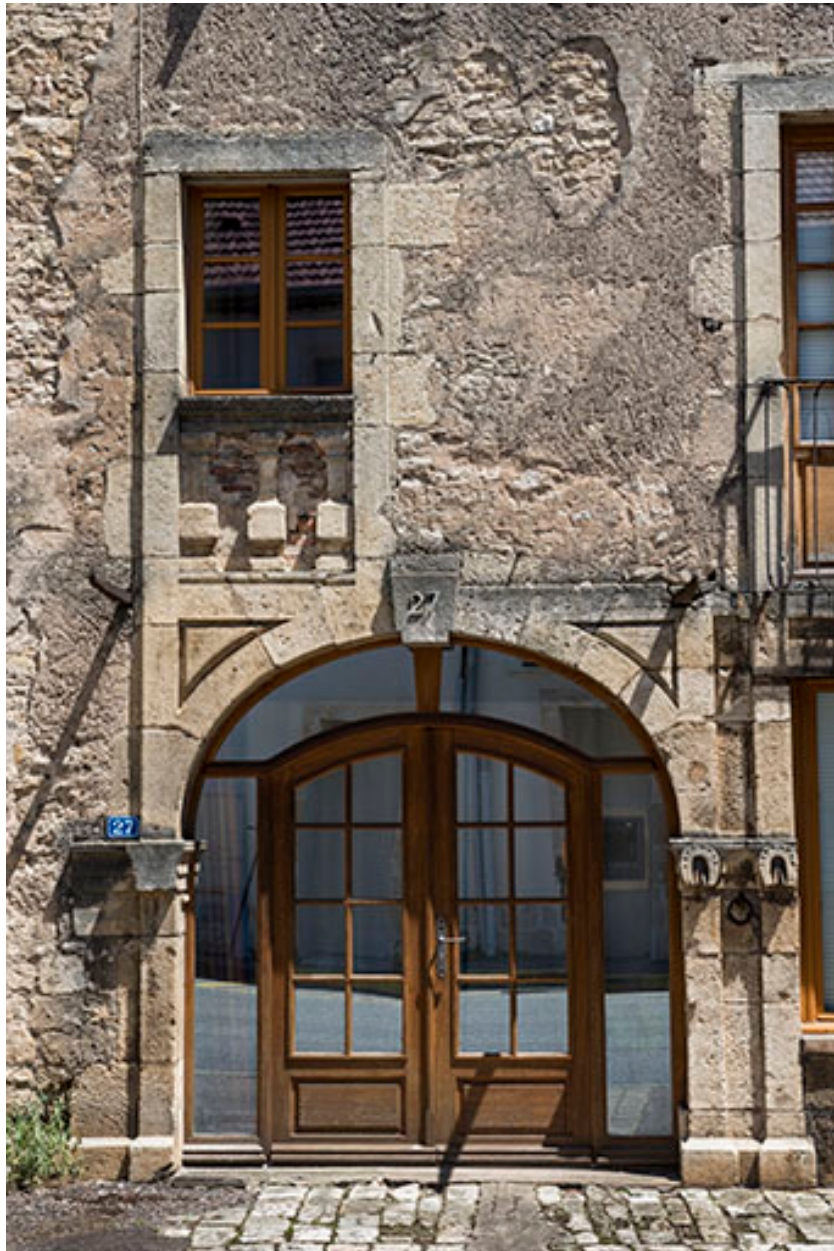
Baies du rez-de-chaussée et du premier étage.
