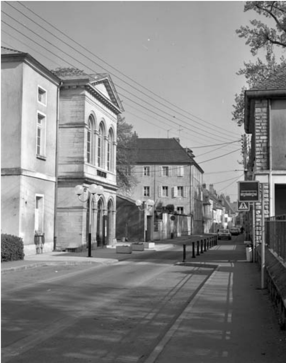
Façade antérieure, de trois quarts gauche depuis l'extrémité de la rue Victor Hugo.
