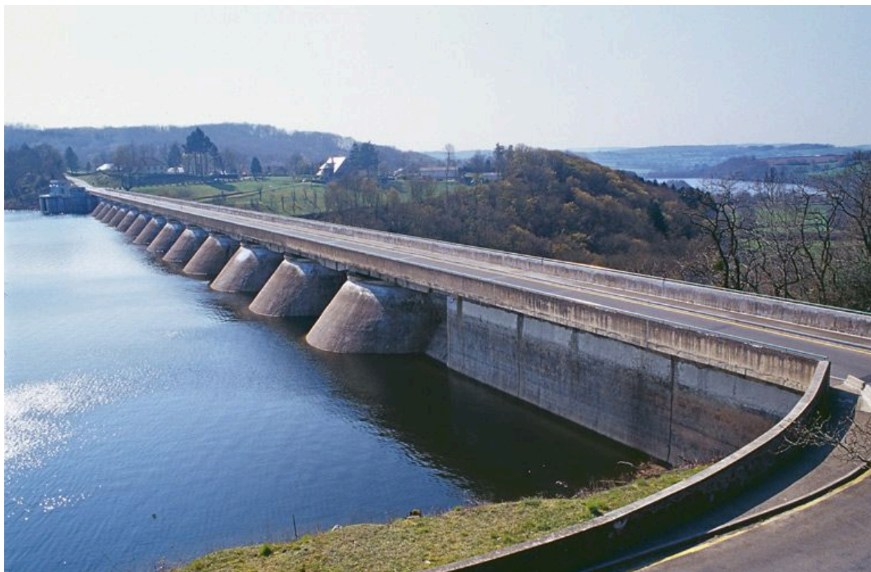
Le barrage-réservoir de Pannecière, vue d'amont. En arrière-plan, on peut voir le bassin de compensation.
