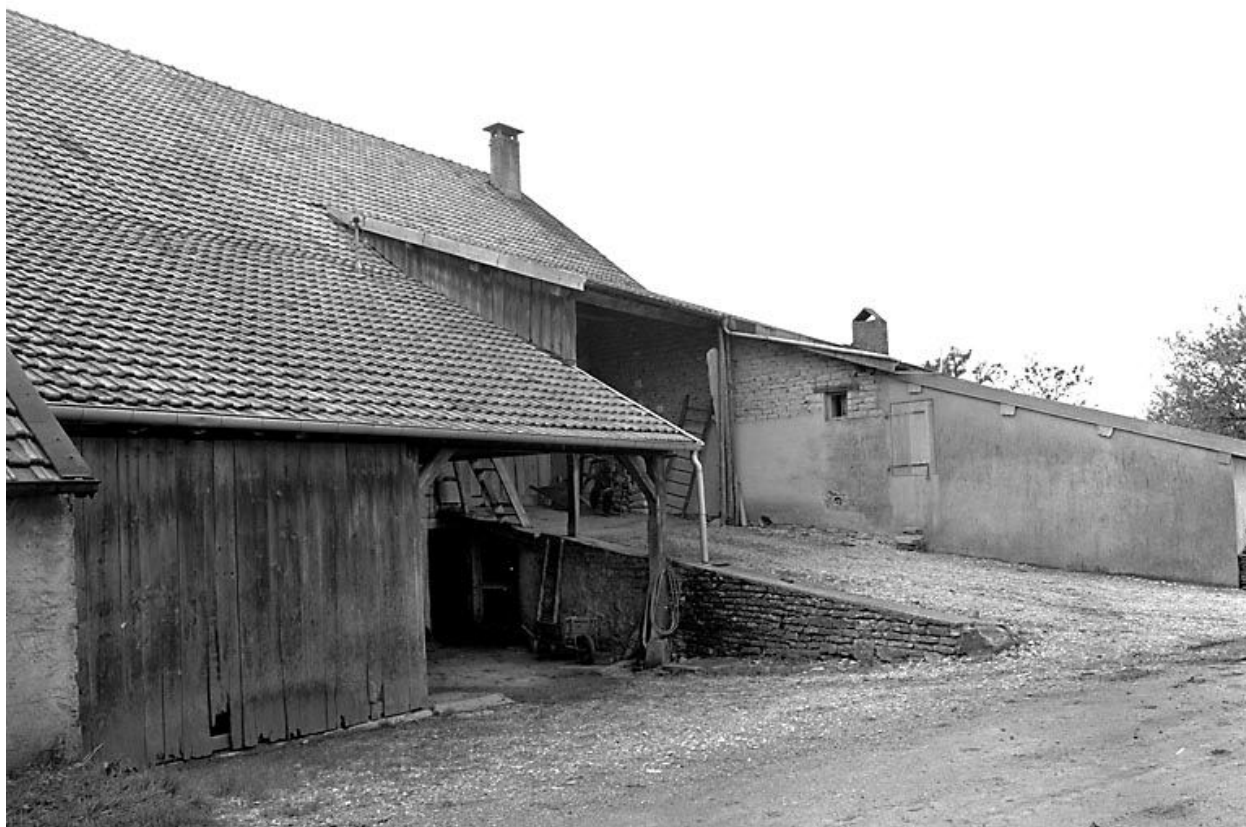
Façade latérale gauche : le pont de grange.
