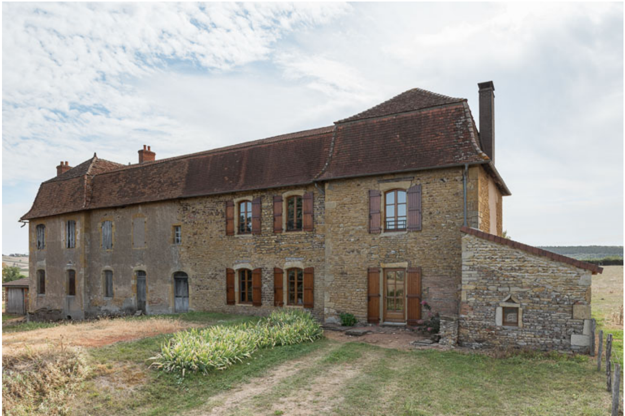
Vue de la demeure ou maison de maître de la Mollière (façade antérieure)
