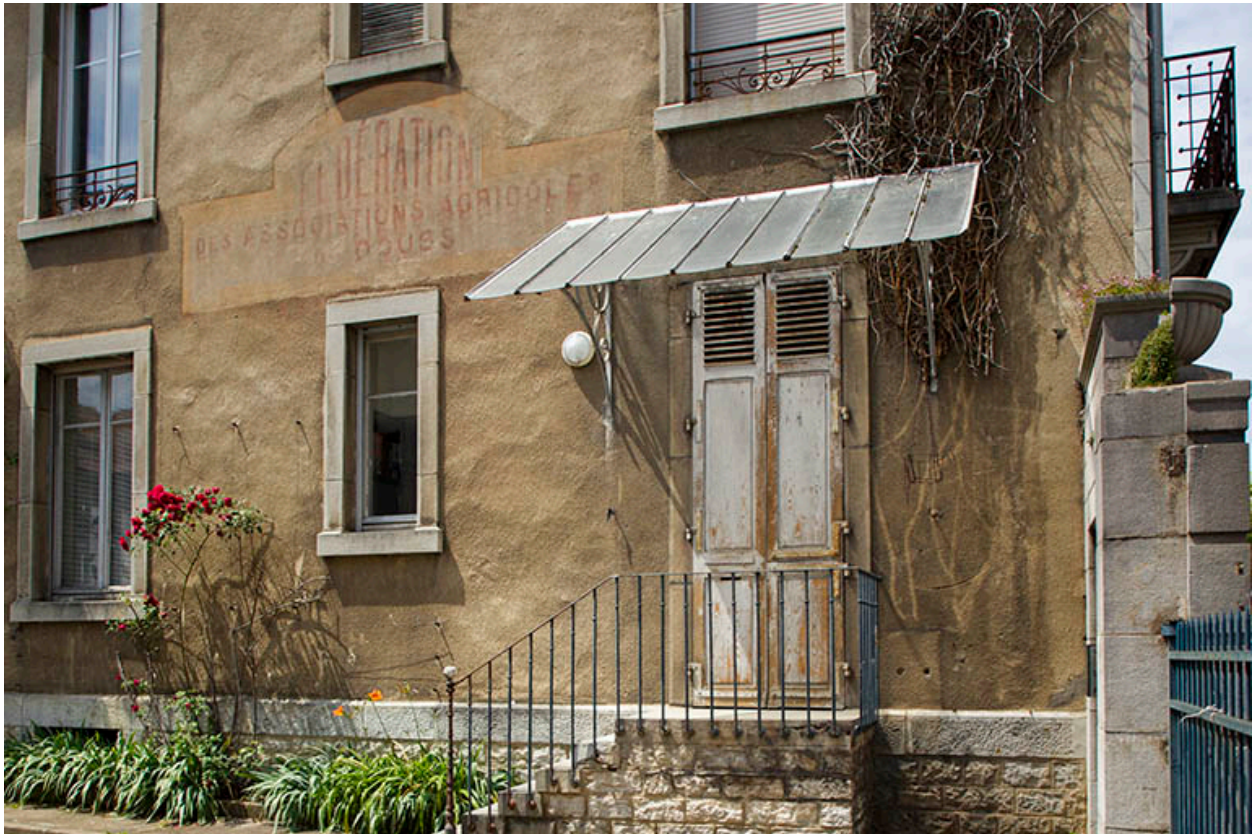
Bâtiment de l'administration : entrée sur la façade latérale gauche.
