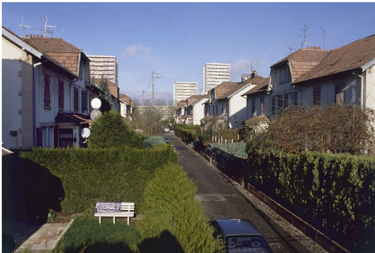
Vue d'ensemble d'une rue.
