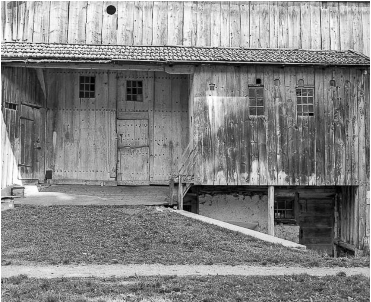
Façade postérieure en 1976 : détail.
