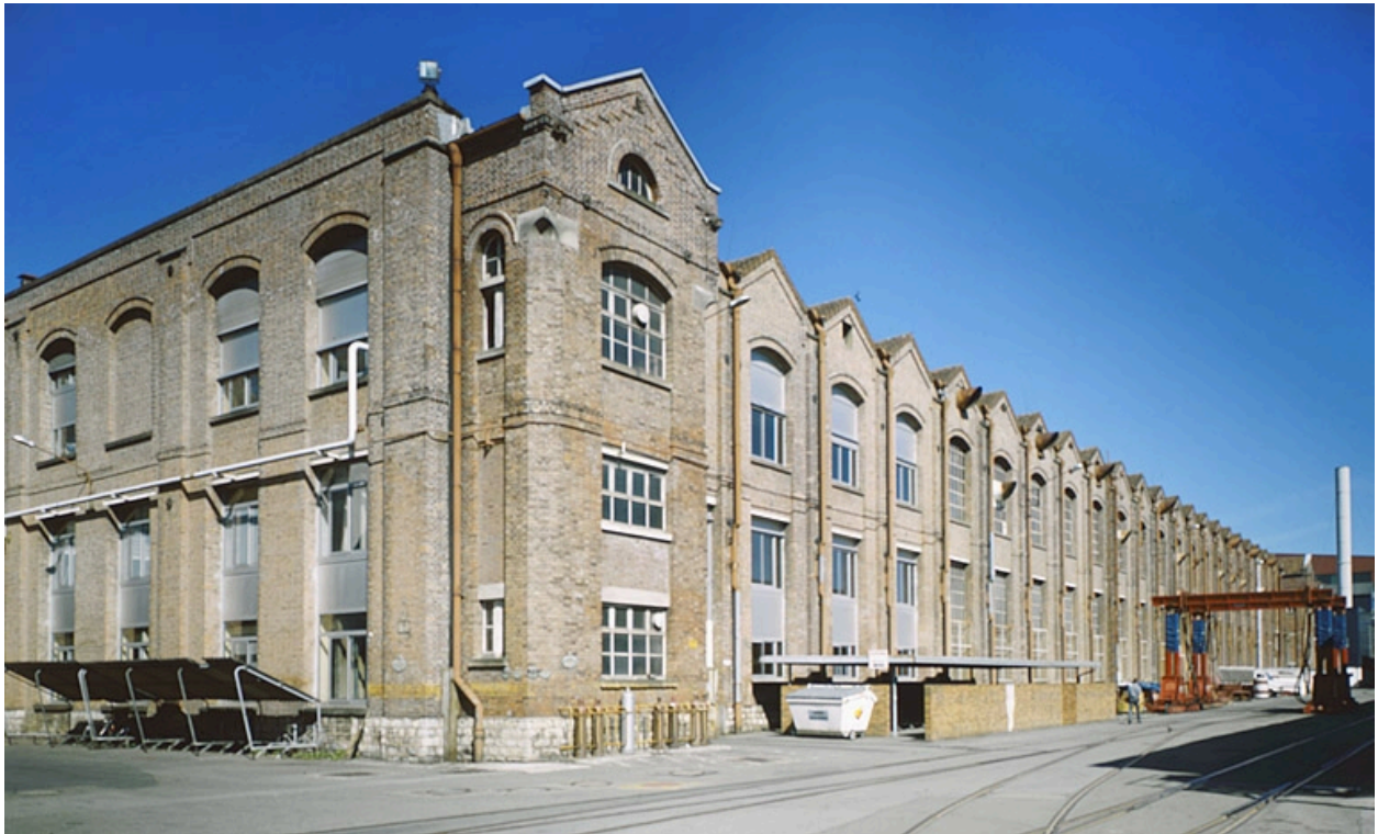
Vue de trois quarts de l'ancien atelier des grandes dynamos.
