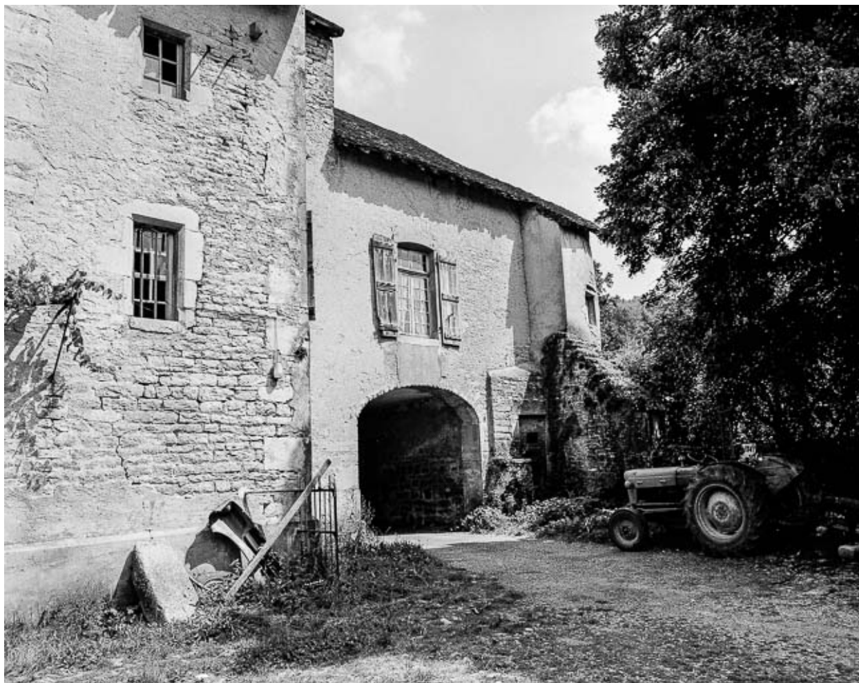
Porche d'entrée, élévation sur la cour.
