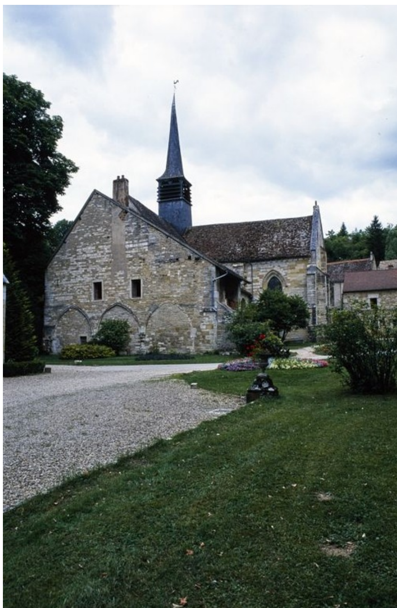
Extrémité nord de l'aile orientale.
