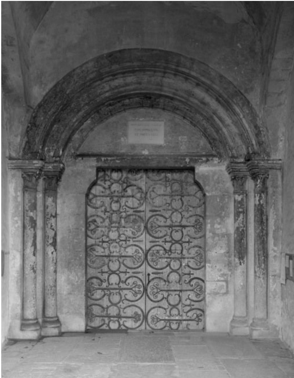
Eglise : porte antérieure de la nef.
