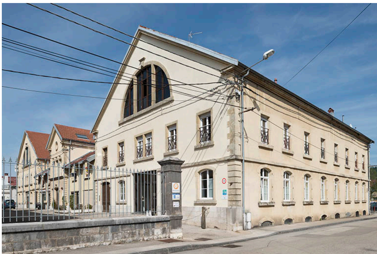
Pignons et façade sud des chais.
