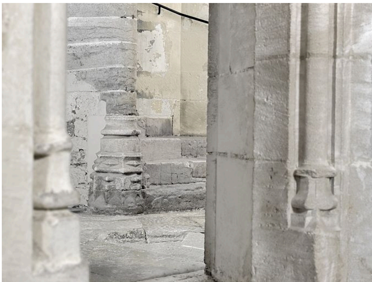
Départ de l'escalier en vis du grand logis.
