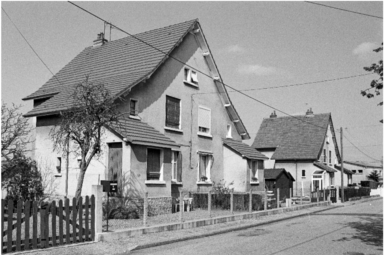
Bâtiment à logements " type 14 ", 1939-1945.
