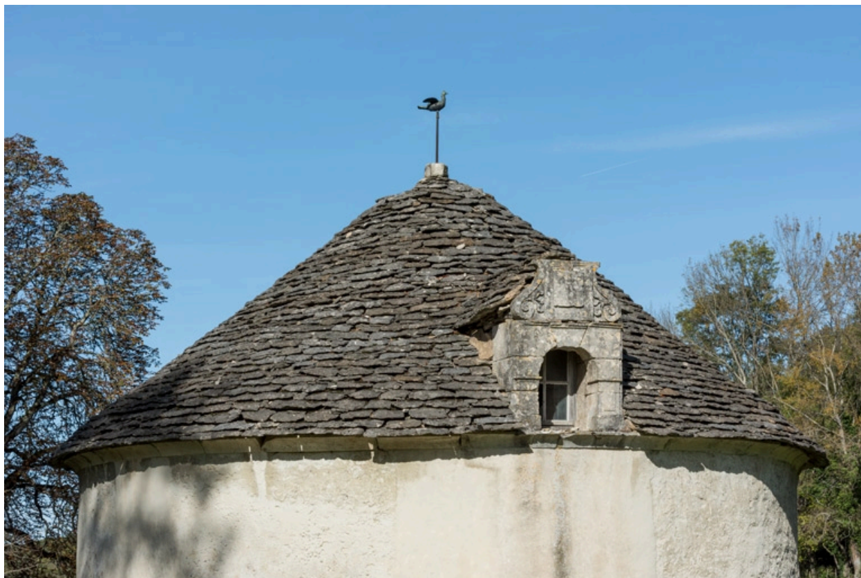
Détail de la toiture.
