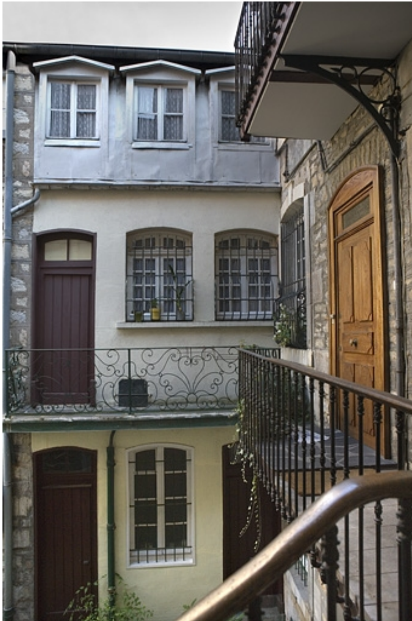
Détail de l'aile droite sur cour depuis l'escalier à cage ouverte.
