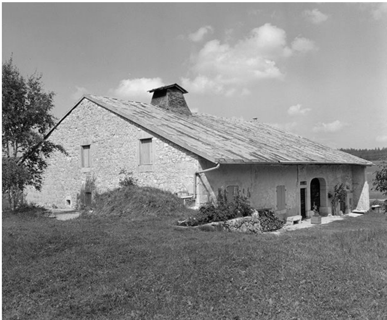
Façades antérieure et latérale gauche.
