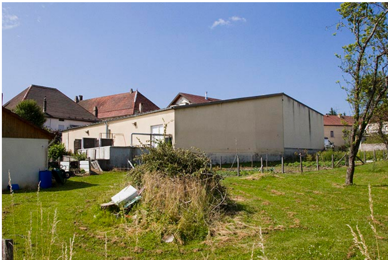
Façades postérieure et latérale gauche des extensions.
