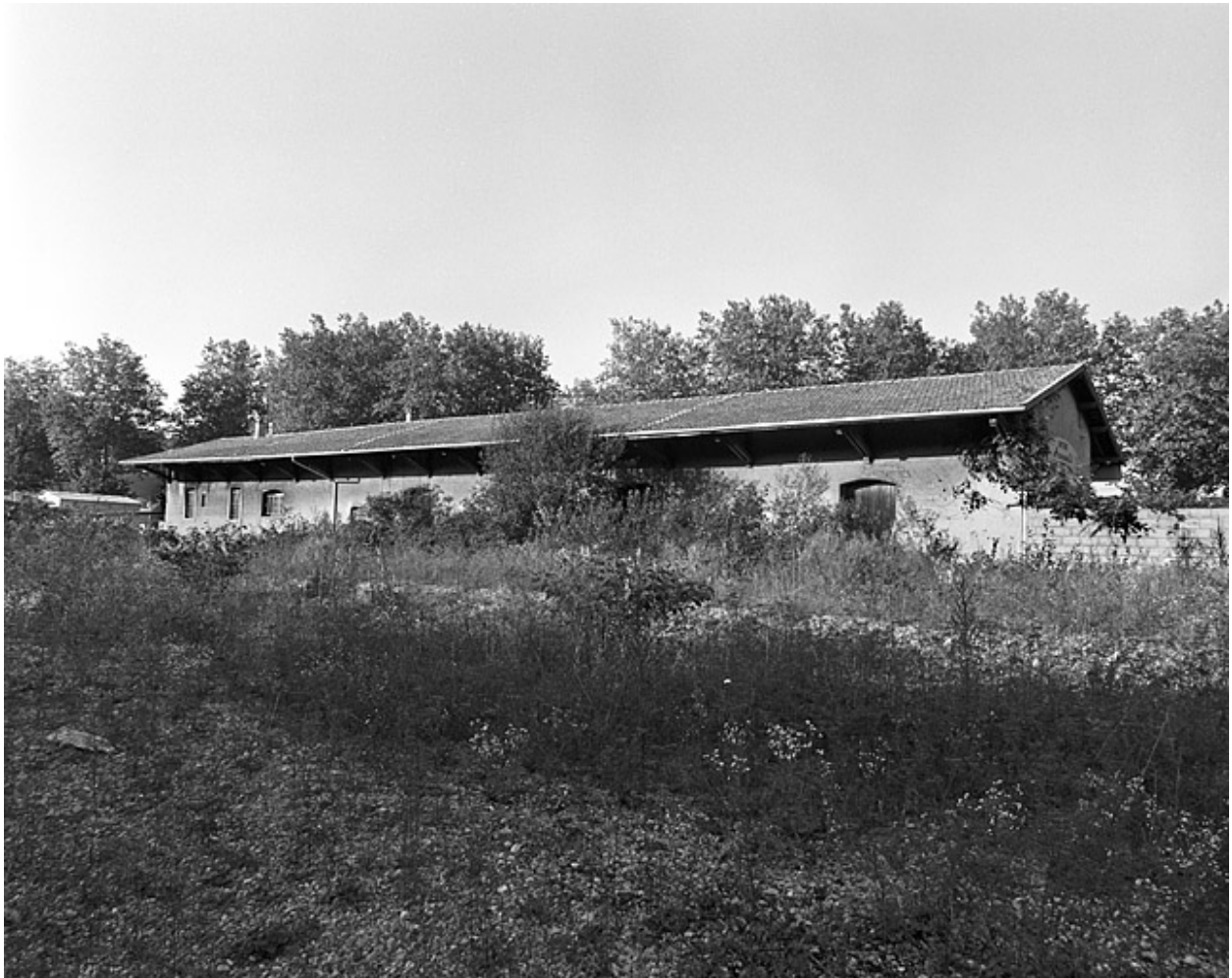
Entrepôt : façade postérieure (côté voies), de trois quarts droite.
