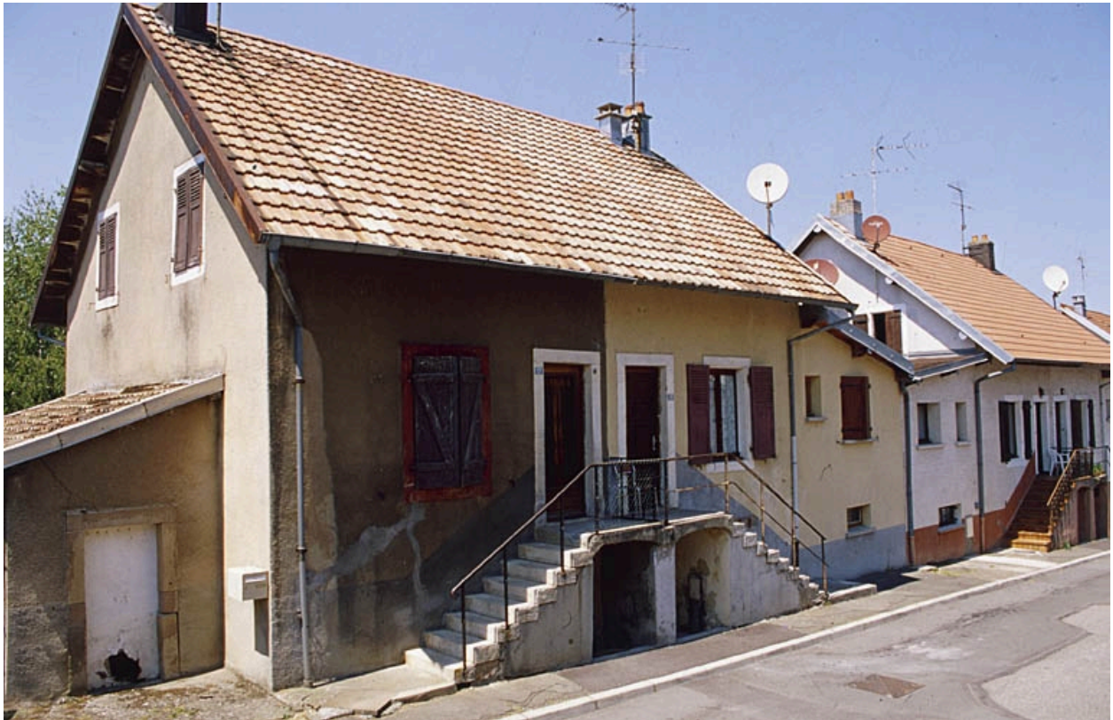
Logement ouvrier double.
