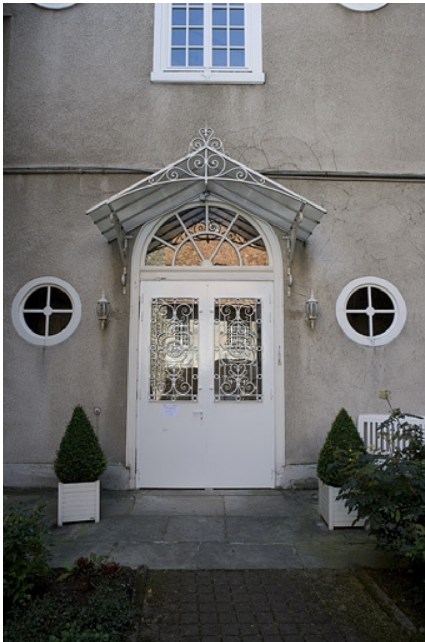
Détail de la porte d'entrée du bâtiment à droite de la cour.
